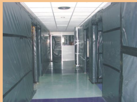
Zone de confinement de travaux de désamiantage
