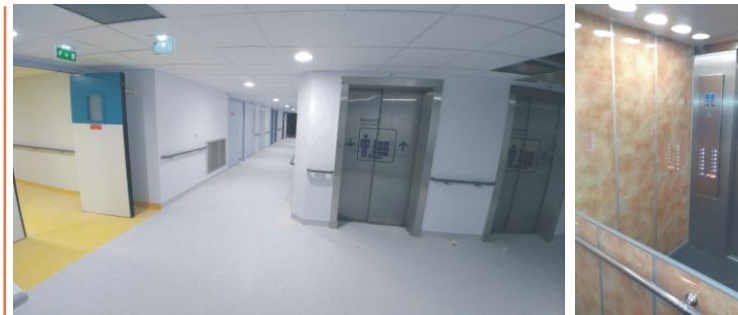
Mise en service des ascenseurs dernière génération 14 appareils
