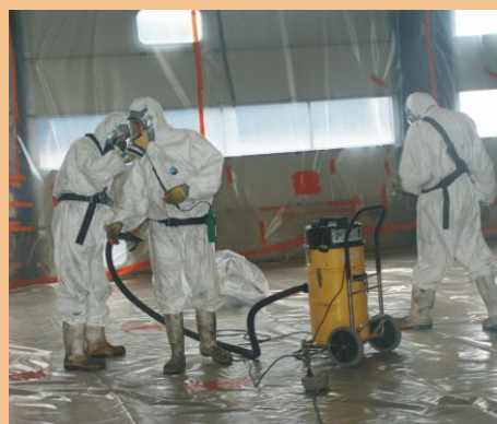
Désamiantage avec équipements de protections individuelles
